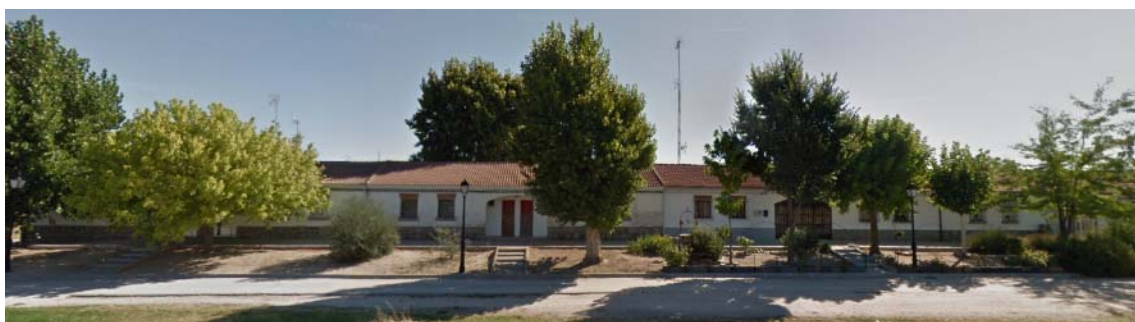
Imagen donde se observa la existencia de alumbrado público en la zona de las edificaciones existentes
