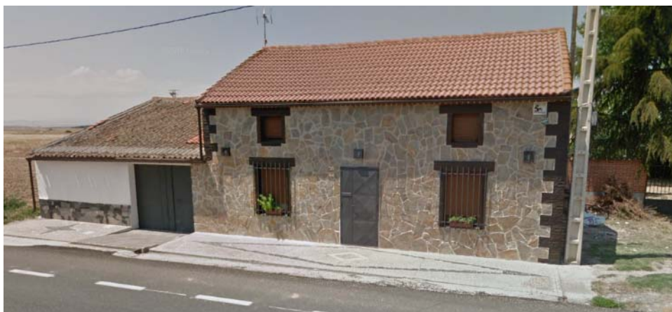
Edificación aislada en la margen izquierda de la carretera, anterior a la entrada en vigor de las NN.SS.PP.
