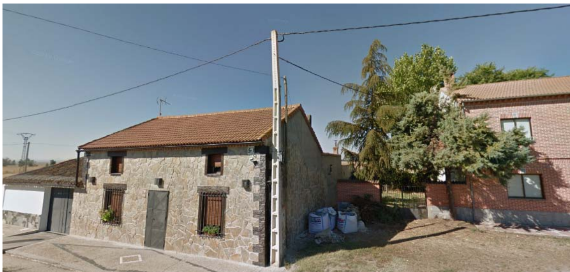
Edificaciones con conexión a los servicios existentes
