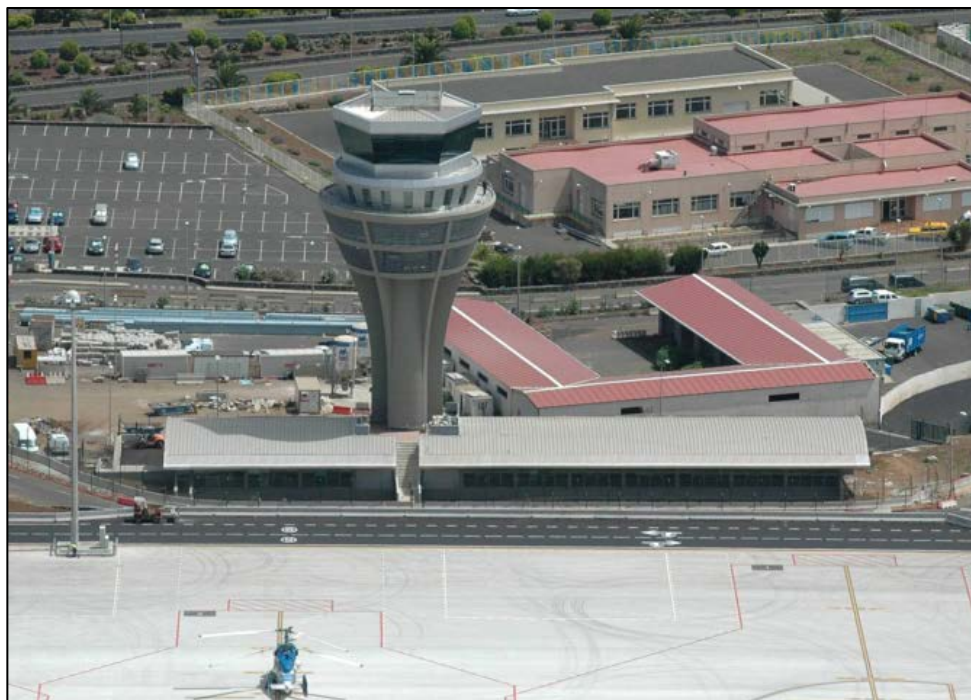
Ilustración 2.16.- Nueva Torre de Control
