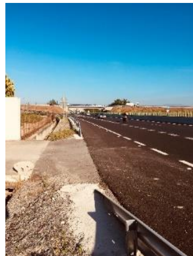
Fotografía 1. Acceso actual al Pozo David
