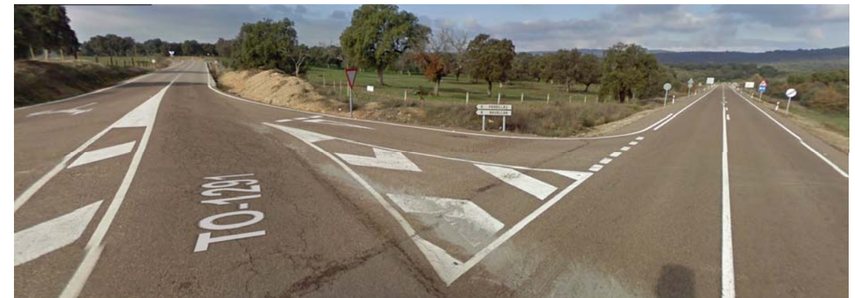
Intersección con la TO-1291 en sentido Ávila
