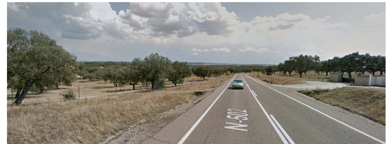
Vista de los accesos del 93+750 en ambos lados de la calzada.
