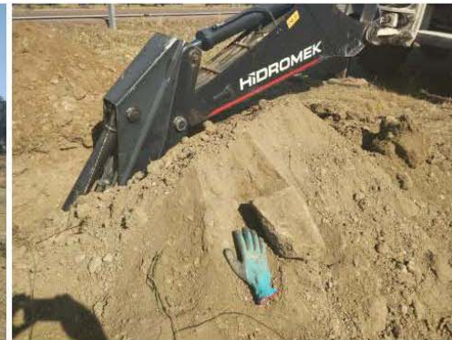
Calicata 1. Relleno arenoso con bloques.
