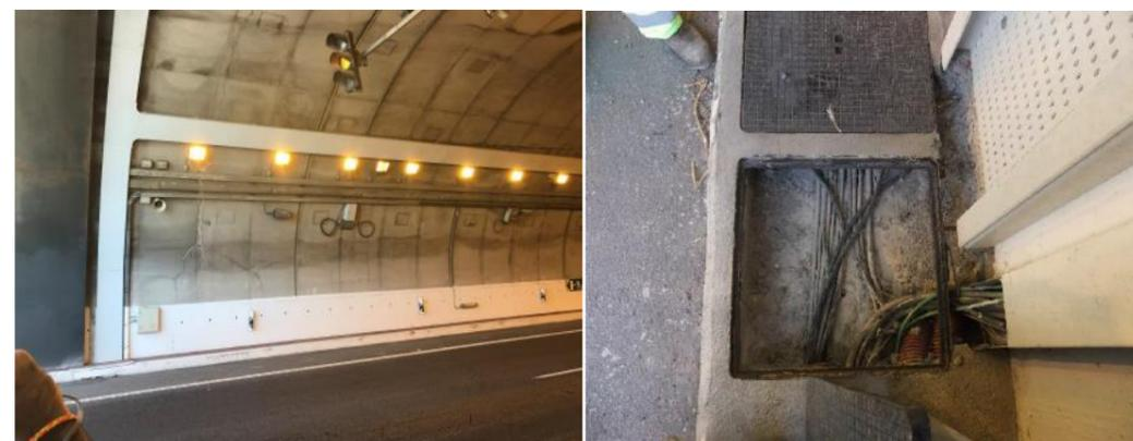
Bandejas situadas en los hastiales (izquierda)- Cables bajo acera en Túnel Sur (derecha)
