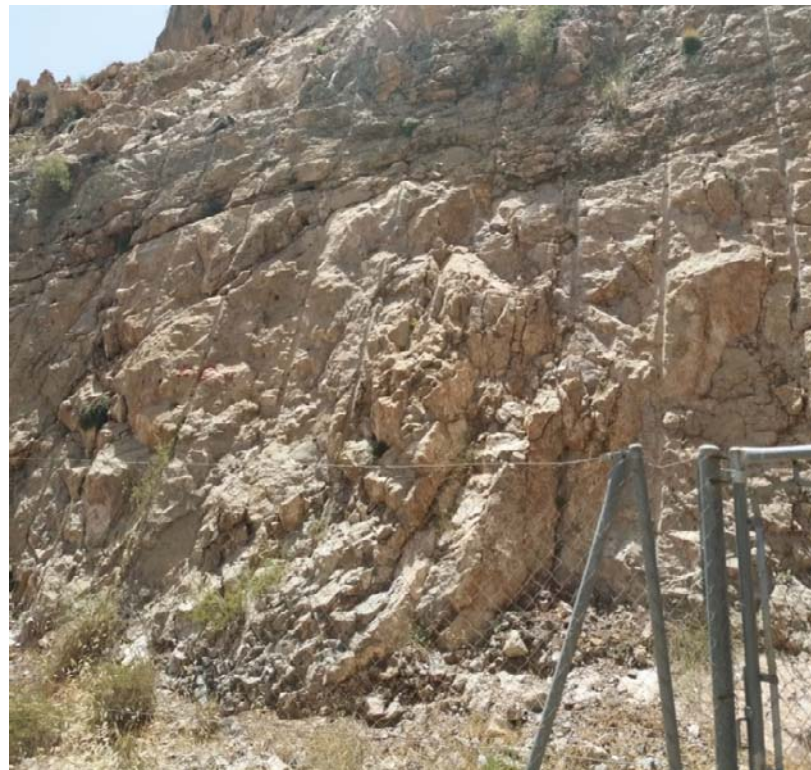
Registro de las cañas de perforación para alojar los barrenos utilizadas en la excavación de un tramo del talud de la actual Autovía A-7, en las inmediaciones del Túnel Sur.
