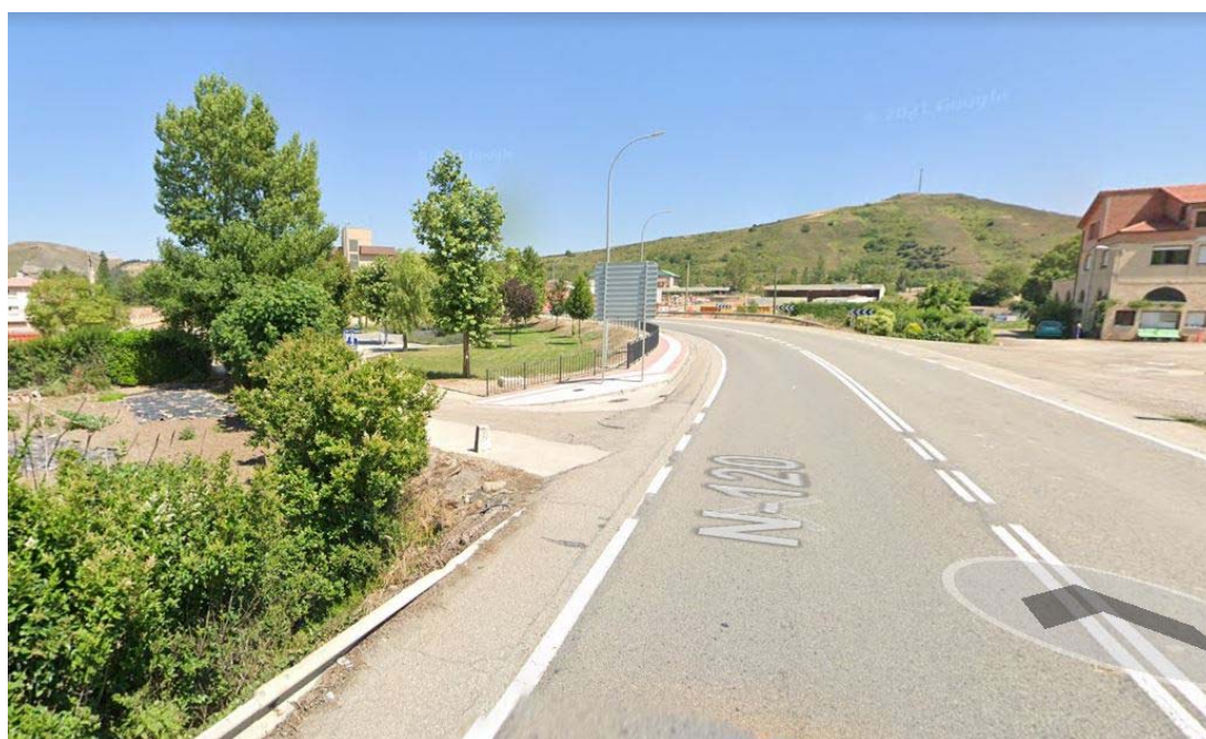
Ctra. N-120 (Sentido Logroño)- TRAMO URBANO 2 Fin de Tramo (a la izquierda de la imagen), encuentro con Camino del Matadero
