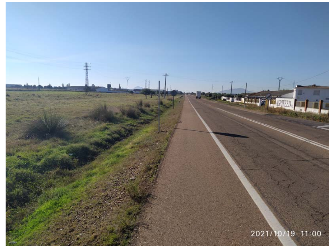
Vista de la carretera actual desde el P.K. 625+714 en sentido +P.K.
