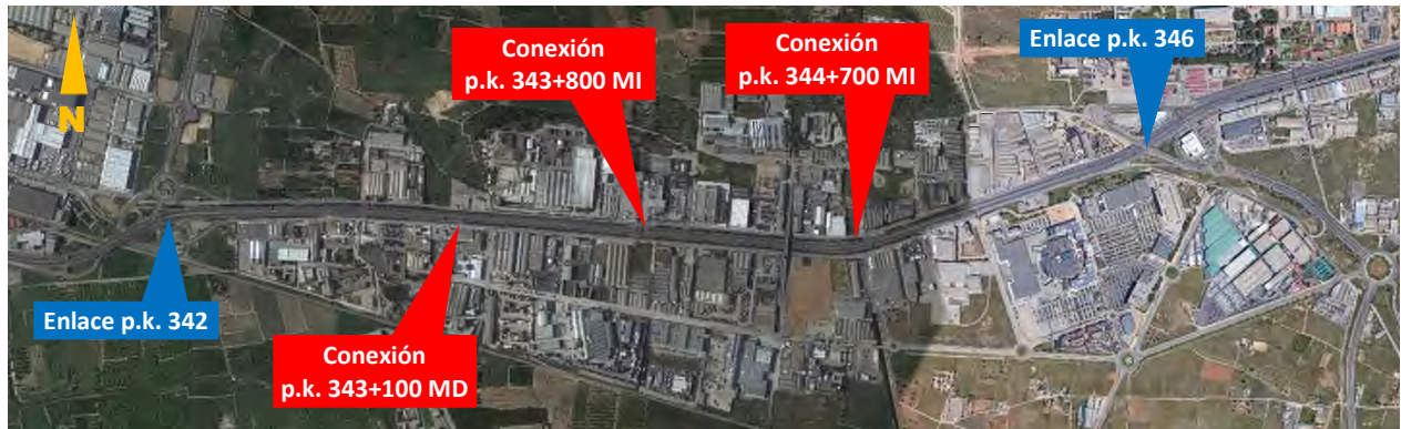
Figura 1. Autovía del Este E-901/A-3, entre los enlaces de los pp.kk. 342 y 346, con vías de servicio paralelas a la autovía, en ambas márgenes y entre los dos enlaces
