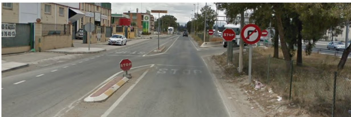
Figura 3. Vía de servicio bidireccional situada en la margen derecha de la autovía. A la derecha de la imagen se aprecia la conexión de la salida procedente del tronco de la autovía, a la altura del p.k. 343+100 MD
