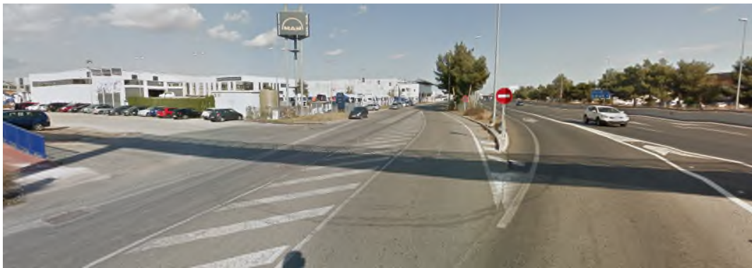
Figura 8. Carril de deceleración del p.k. 343+800 MI de la A-3, visto desde el carril de la vía de servicio con un sentido de circulación opuesto al de la autovía, en la que se aprecia la relativa facilidad de entrada a la autovía, por error o distracción, en contradirección
