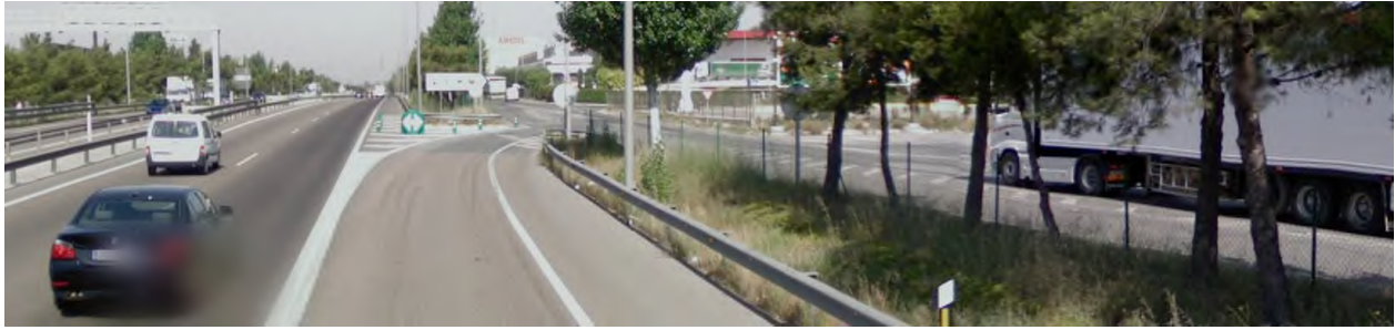
Figura 4. Salida del tronco de la autovía hacia la vía de servicio bidireccional de la margen izquierda, a la altura del p.k. 343+800
