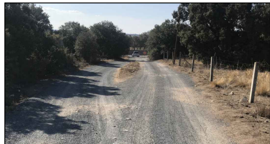
3_TRAMO QUE UNA LA N-403 CON EL PASO A NIVEL
