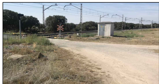
9_ZONA DE EMPLAZAMIENTO DE INSTALACIONES AUXILIARES DE LA OBRA
