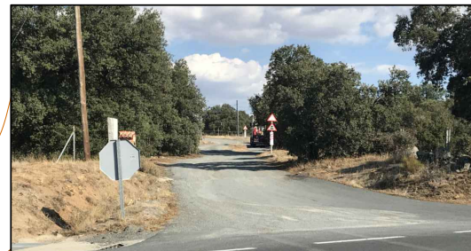
1_ACCESO A PASO A NIVEL DESDE CARRETERA N-403
