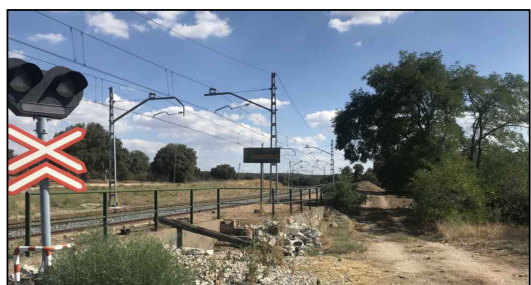
5_RUINAS DEL APEADERO DE EL PEDROSILLO. ANDÉN DE LA MARGEN IZQUIERDA
