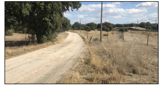
14_ ZONA PREVISTA PARA LA EJECUCIÓN DEL ESTRIBO 2 DEL PASO SUPERIOR
