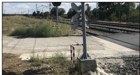
7_MARGEN DERECHA DEL APEADERO DE EL PEDROSILLO CAMINO DEL MOLINO. ACCESO DERECHO AL PASO A NIVEL
