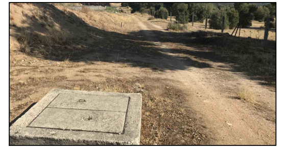
13_ MARGEN IZQUIERDA DE LA VÍA. CANALIZACIÓN DE INSTALACIONES DE ADIF
