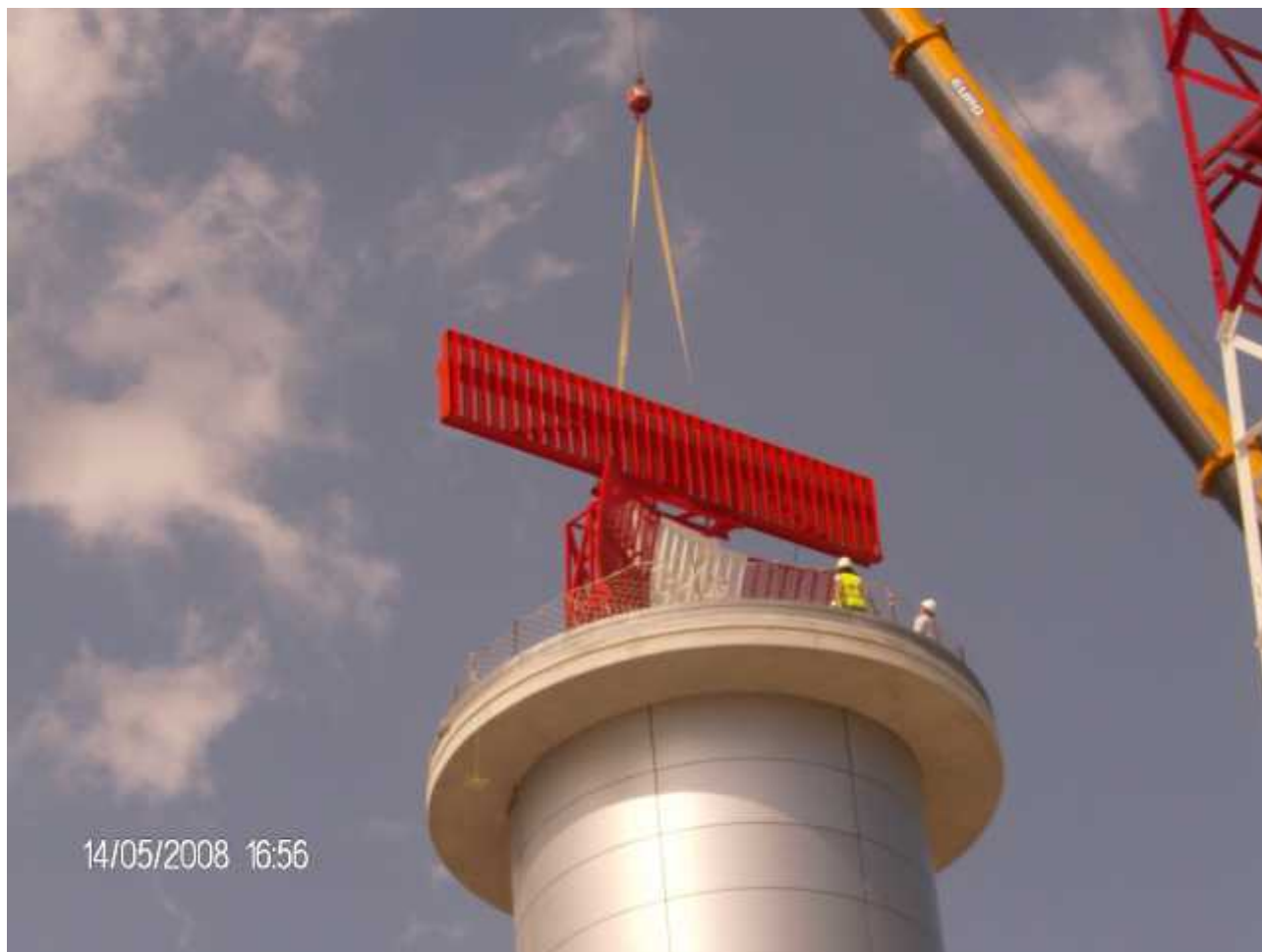
Figura 3. Instalación antena de secundario sobre antena de primario
