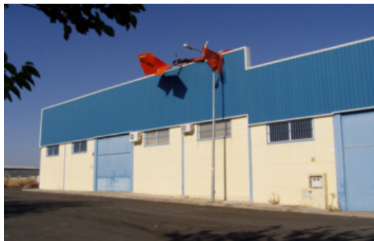
Figura 3. Posición de la aeronave vista desde la calle
