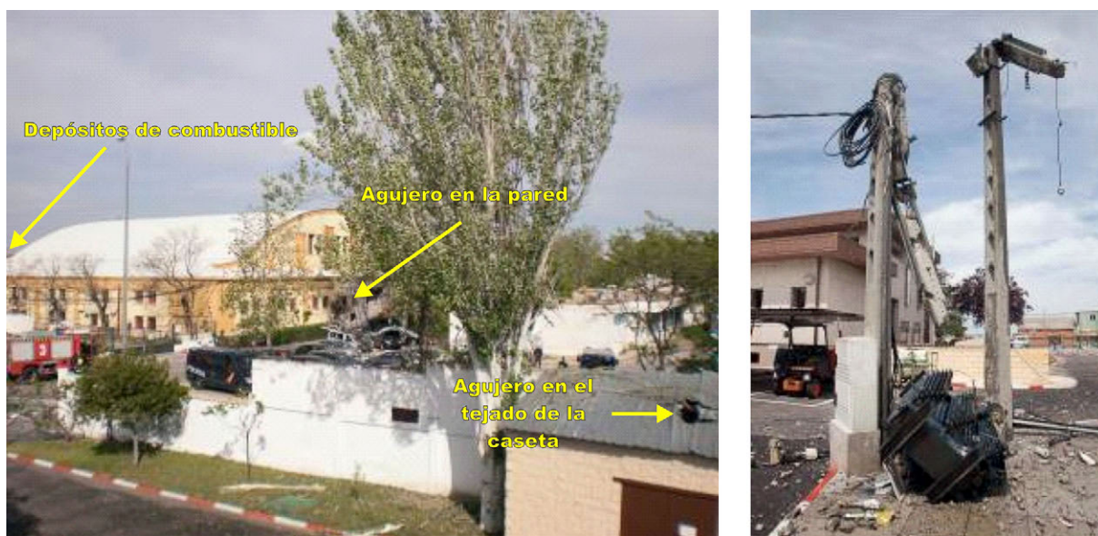
Figura 4. Daños en hangar y en transformador
