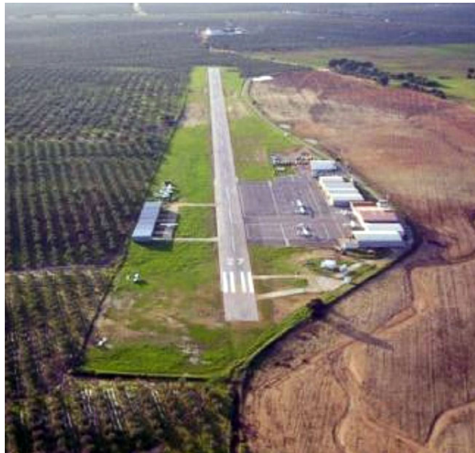
Figura 2. Vista aérea de La Juliana
