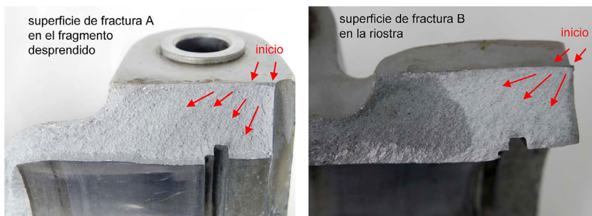
Figura 5. Detalle fracturas A y B
