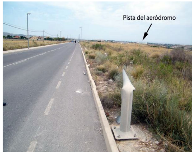
Figura 4. Estado final de la farola A
