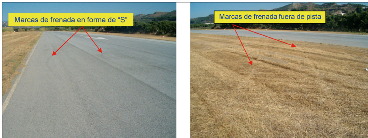
Figura 4. Fotografías de las marcas de frenada dentro y fuera de la pista
