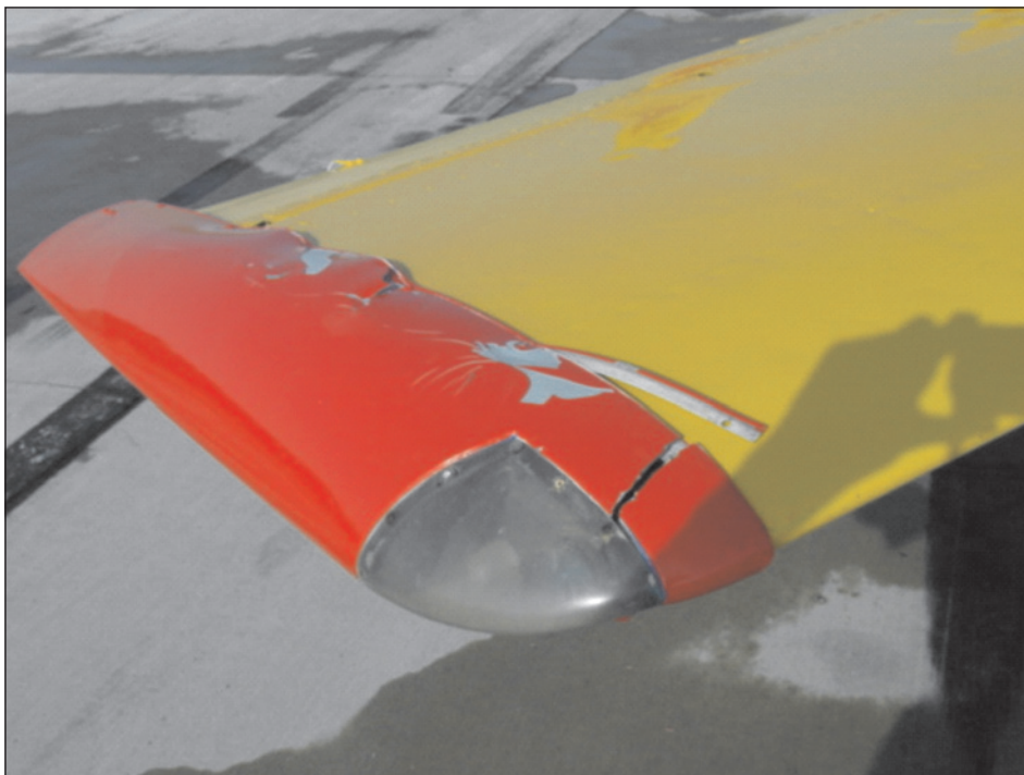
Foto 2. Detalle de daños en el borde marginal del plano izquierdo
