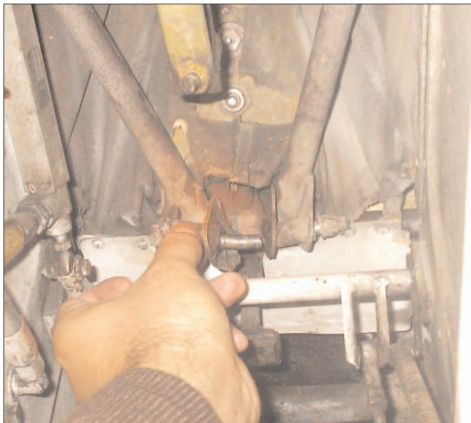
Fotos 1 y 2. Del pozo del tren delantero, visto hacia atrás del avión. El herraje derecho (a la izquierda de la foto) se desprendió con parte del tornillo y apareció 4 m detrás del punto en el que se detuvo el avión
